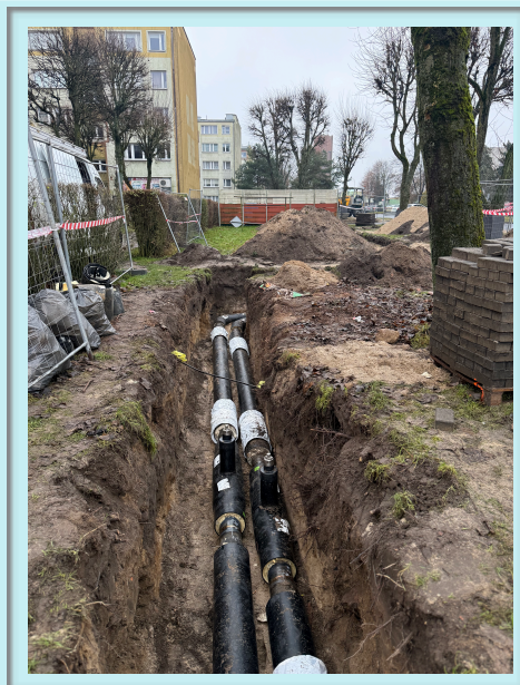
Budowa sieci ciepłowniczej wysokoparametrowej w ciągu ulic Średnia i Wyszyńskiego
