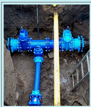
Wymiana węzłów wodociągowych ul. Leśna
