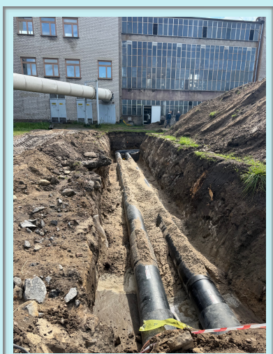
Budowa sieci ciepłowniczej wysokoparametrowej przy kotłowni KR 1
