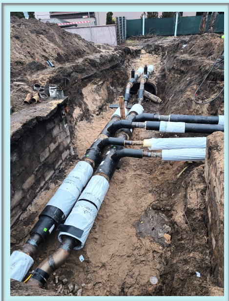
Budowa sieci ciepłowniczej wysokoparametrowej w ciągu ulic Średnia i Wyszyńskiego
