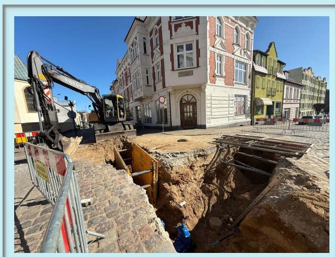
Wymiana węzłów wodociągowych ul. Królewska
